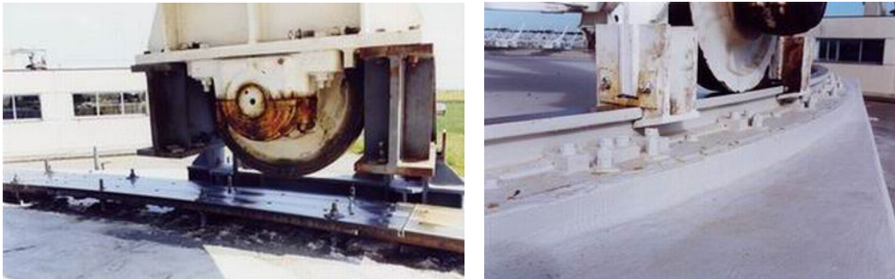
Fig. 2.2: Posa della lastra metallica (antenna sollevata) e lavoro finito (la lastra e il grout sono verniciati in modo uniforme)
